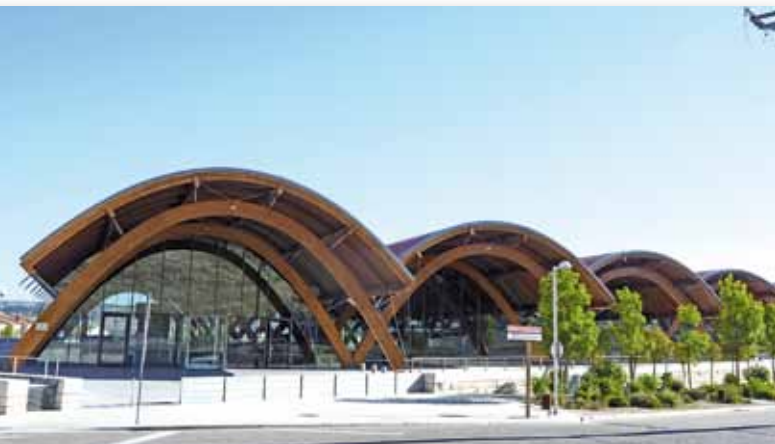
LE NOUVEAU CHAI DE BODEGAS PROTOS. Son toit est formé de cinq gigantesques tuiles canal supportées par des arches en bois verni. © M. HULOT
